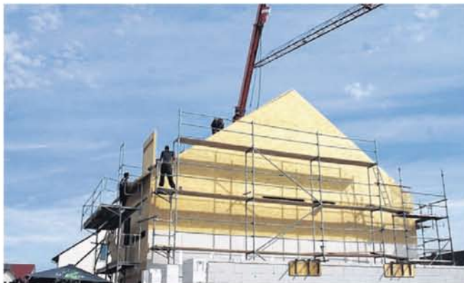
Tag drei, 14 Uhr: Jetzt kann schon bald verputzt werden.
