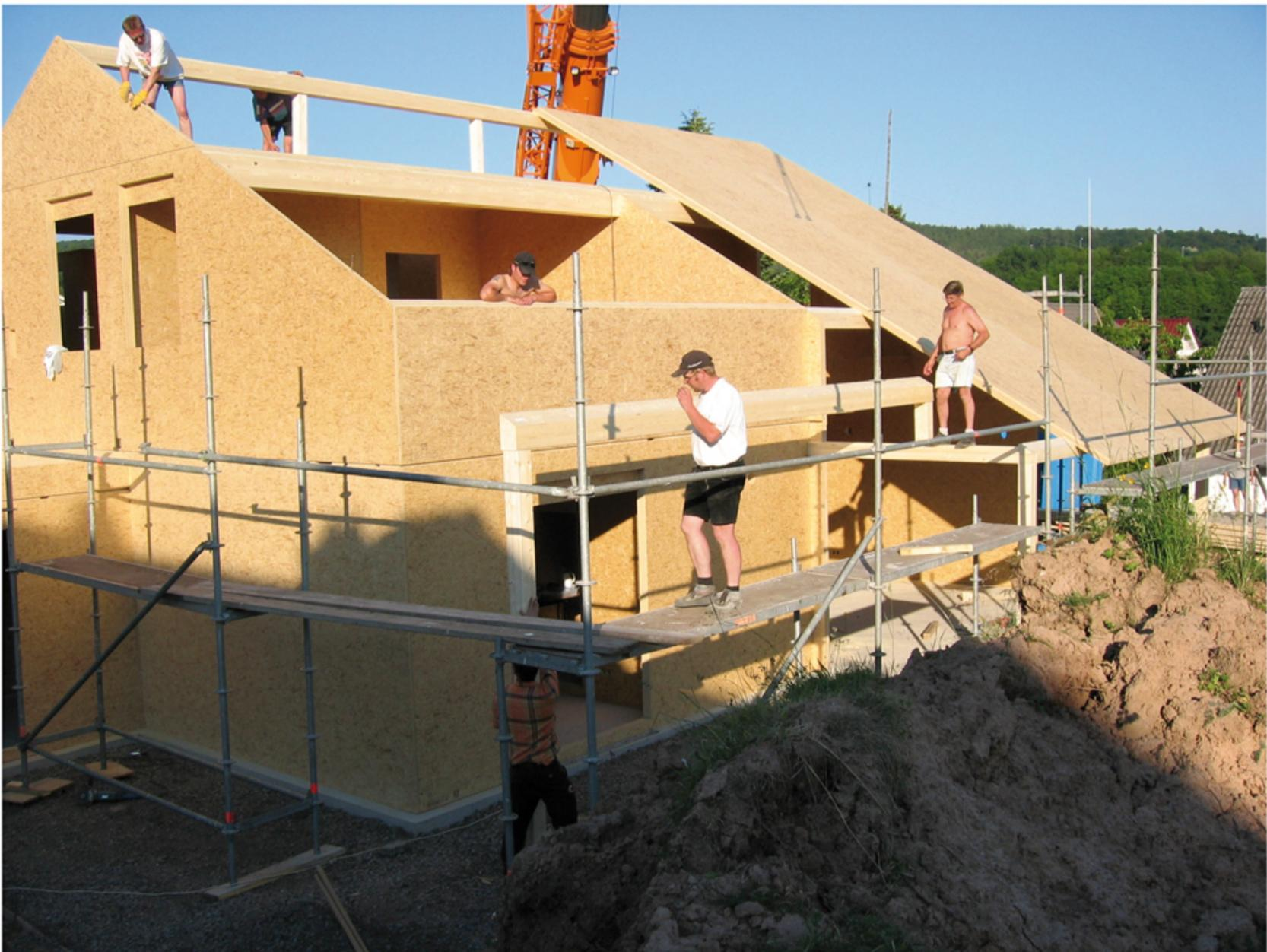
Bauteile können in Breiten von bis zu 3,40 m und Längen bis zu 15 m auf eigens dafür konzipierten modernen Produktionsanlagen hergestellt werden. Diese Anlagen erlauben die wirtschaftliche Herstellung auch geometrisch komplizierter Formen auf einfache Art und Weise mit höchster Präzision.
