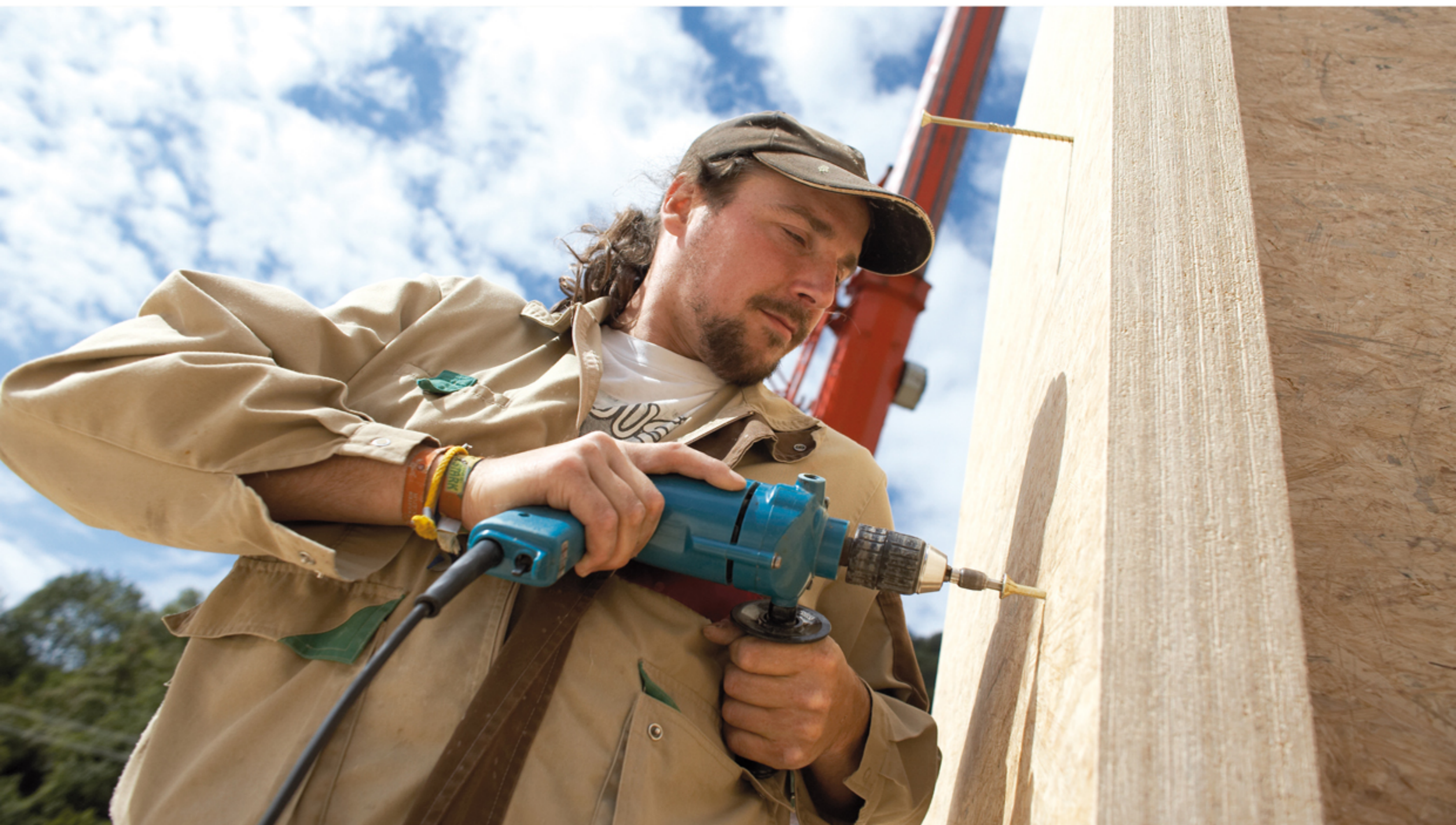
hoch belastbare Konstruktionen sind durch einfache Verschraubungen möglich
