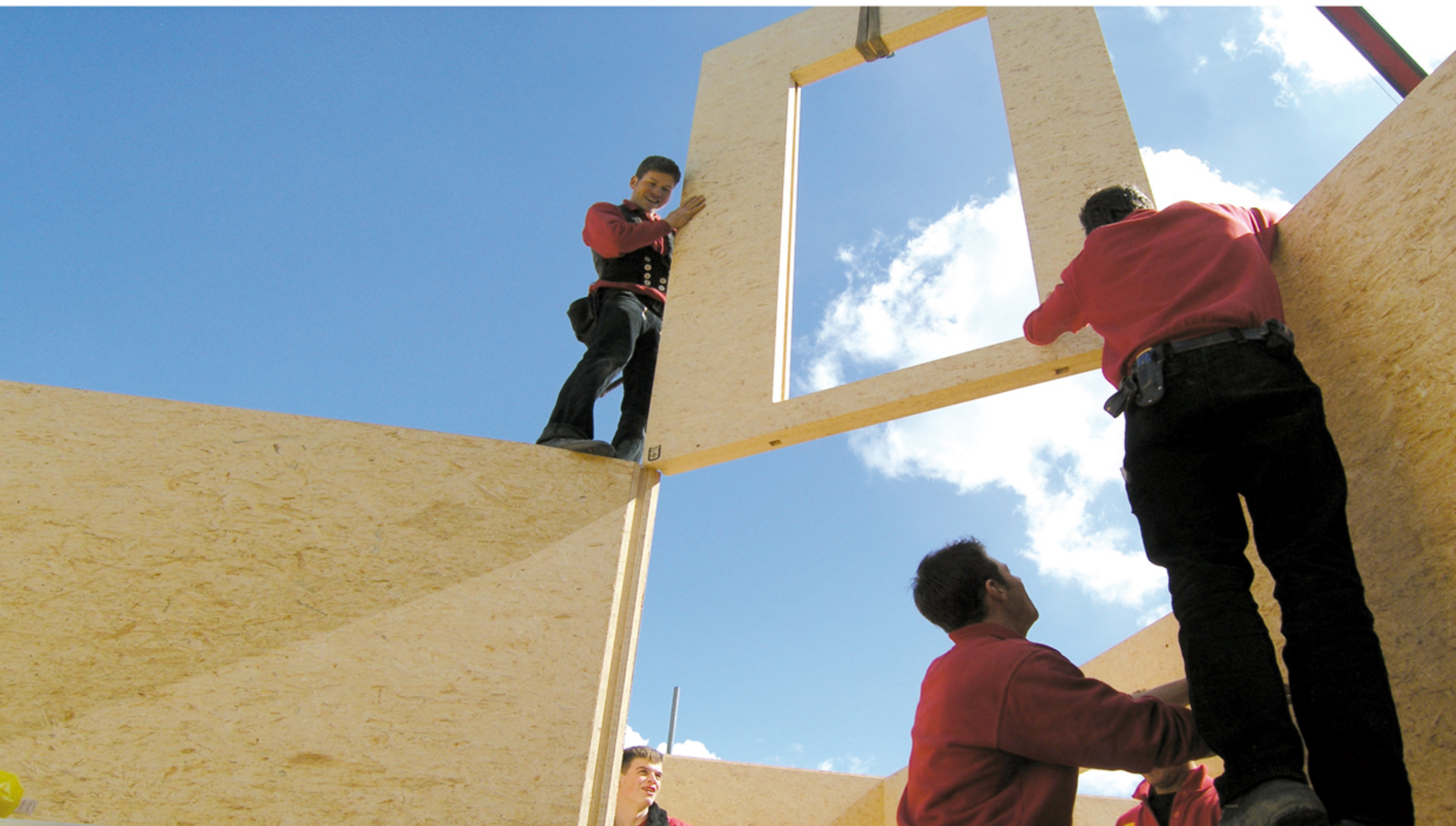
eine durchdachte Stapelreihenfolge ermöglicht die schnelle Montage
